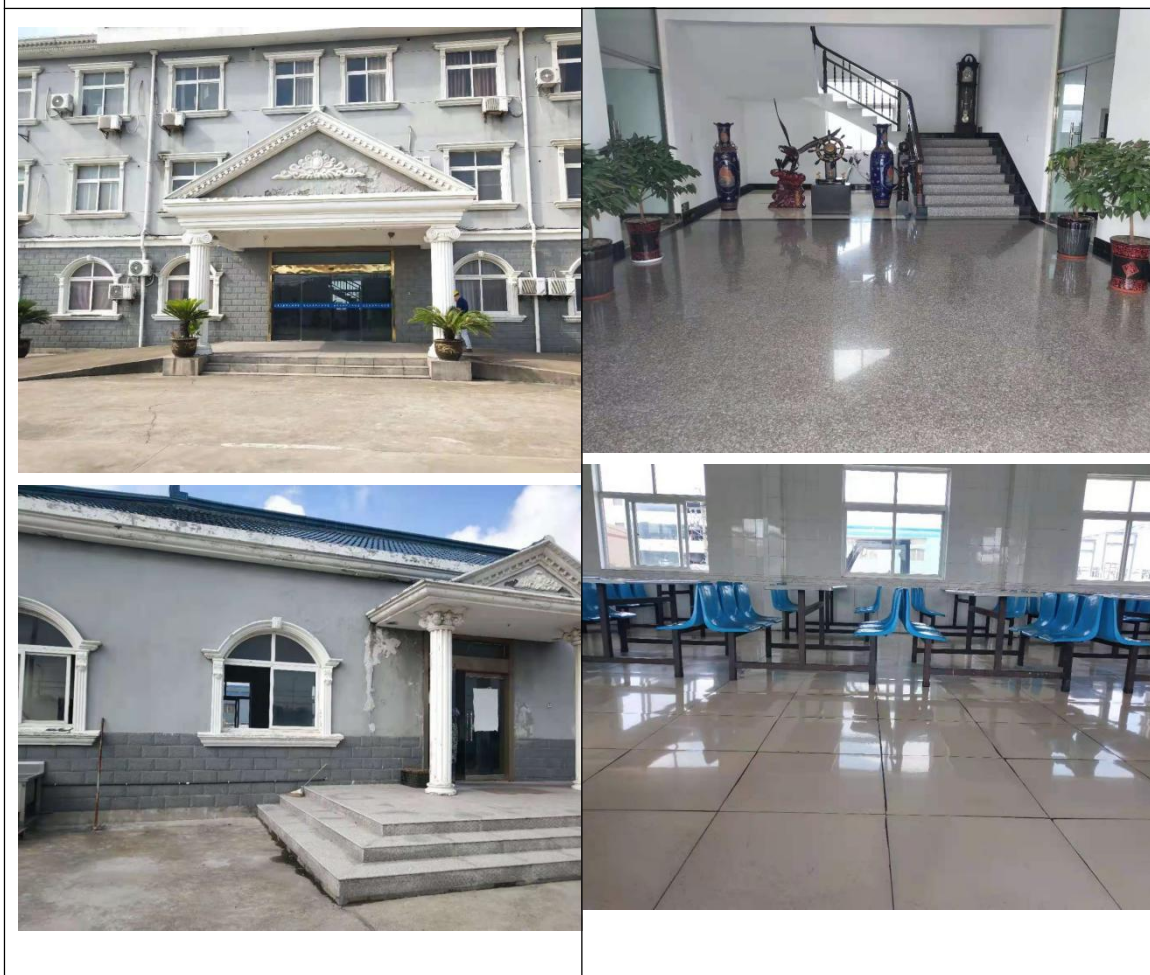
办公楼及员工食堂：地面已做硬化处理，无破损。
