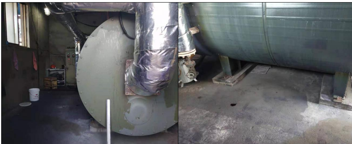
锅炉房：地面均已硬化，无明显裂痕。
