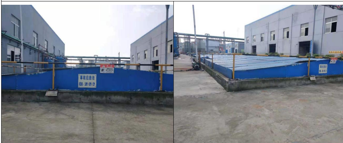
事故应急池：为地下实池体，地面均已硬化，无破损。
