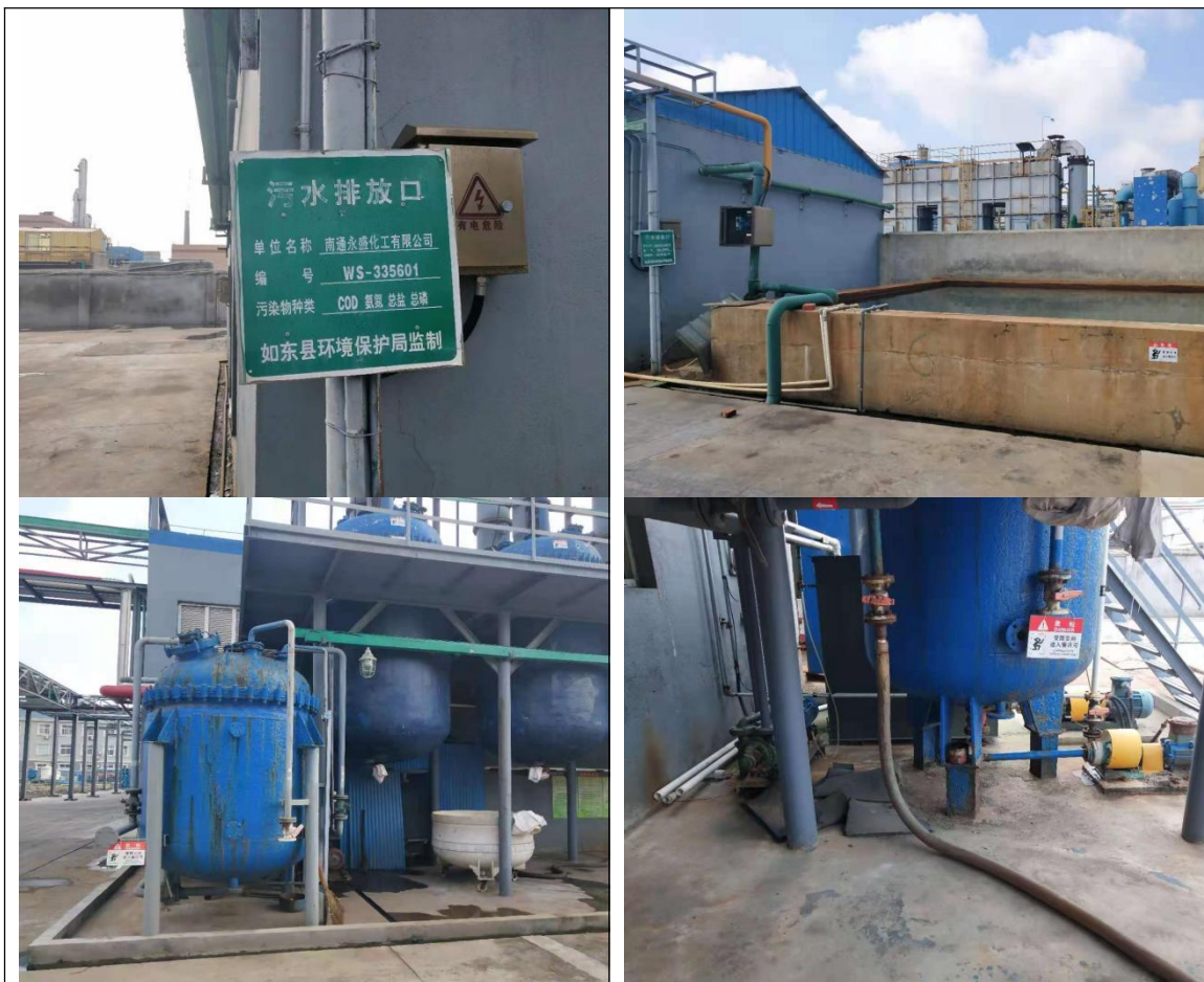
污水处理区：地面均已硬化，无破损，四周设有围堰，导排沟。
